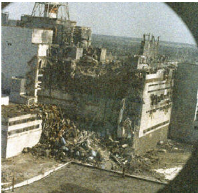
Destruction du réacteur à cause de l'explosion
